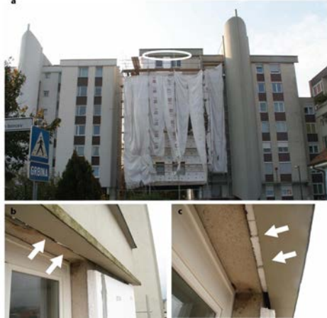
Slika 5: Obnovitvena dela fasade na Kumrovški ulici 11. A – nameščanje izolacije (stiropor), ki je na vrhu zaprla vhod v zatočišče (Foto: Maja Zagmajster), B – špranja nad oknom v sedmem nadstropju, ki so jo netopirji pred obnovo uporabljali za vhod (Foto: Matej Hočevar) in C – zapiranje špranje z stiroporom (Foto: Matej Hočevar) (vzeto iz Hočevar, 2009).
