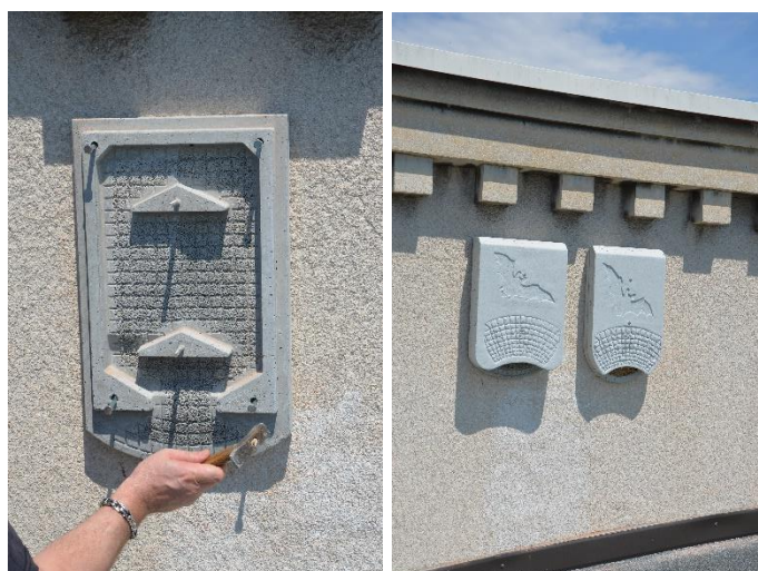
Slika 2: Nameščanje stavbnih netopirnic na Vilharjevi 11 (Foto: S. Zidar)
