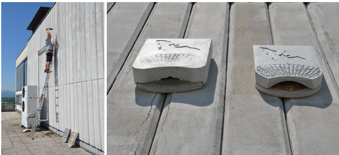
Slika 4: Nameščanje stavbnih netopirnic na stavbi Strojne fakultete (Foto: S. Zidar).
