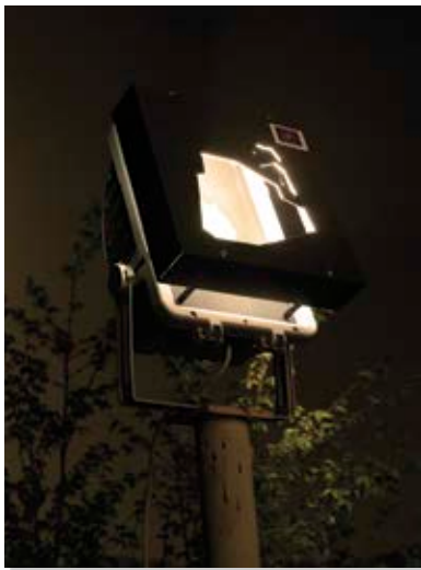
Svetilka z masko je narejena na osnovi MH sijalke s 3000 K in dodatno vgrajenim filtrom, ki ne prepušča UV in modre svetlobe.
